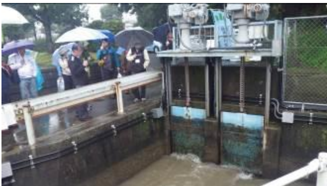
徐々に樋門が上がる様子を興味深く見学！
