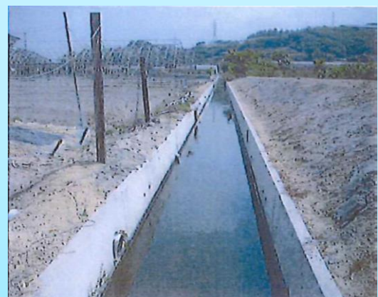
三面コンクリート水路
