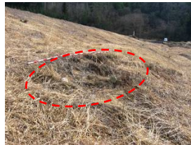
堤体の陥没
