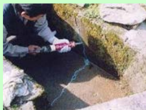
水路のひび割れ補修
