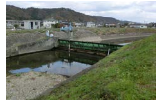
頭首工の診断
