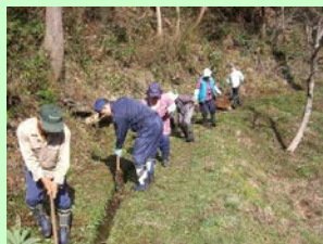
水路の泥上げ
