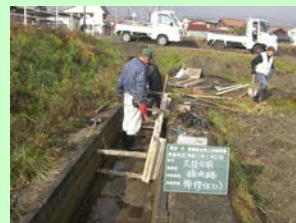
水路の補修・更新
