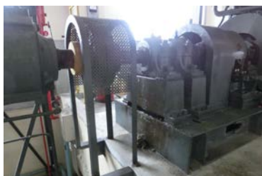
【排水機場 グリス漏れ】
