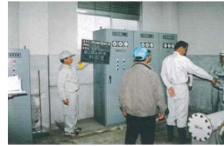
揚水機の診断
