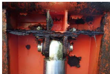
【可動堰 堰体部材腐食】
