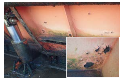
【可動堰 堰体塗装劣化】
