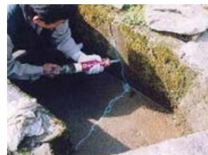
【水路のひび割れ補修】
