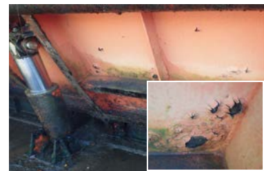
【可動堰 堰体塗装劣化】
