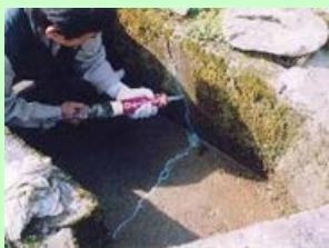
水路のひび割れ補修
