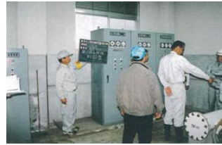
揚水機の診断
