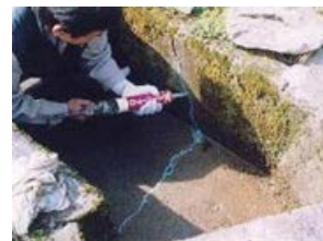
【水路のひび割れ補修】
