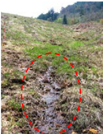
堤体からの漏水
