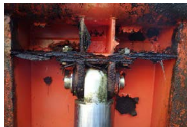
【可動堰 堰体部材腐食】
