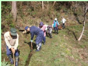
水路の泥上げ
