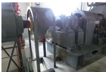
【排水機場 グリス漏れ】
