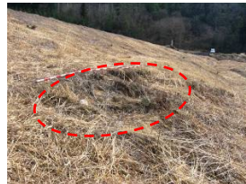
堤体の陥没
