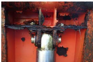
【可動堰 堰体部材腐食】
