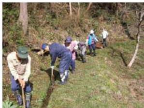
【水路の泥上げ】
