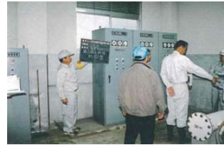
揚水機の診断
