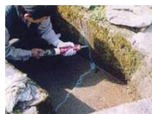
【水路のひび割れ補修】
