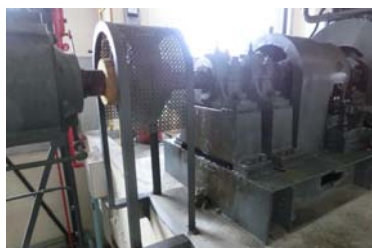
【排水機場 グリス漏れ】
