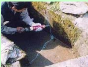
水路のひび割れ補修
