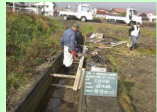
水路の補修・更新
