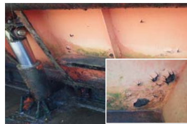
【可動堰 堰体塗装劣化】
