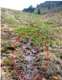
堤体からの漏水
