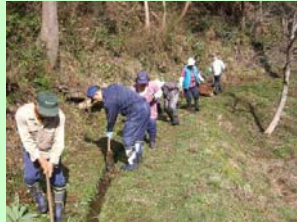
水路の泥上げ
