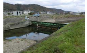
頭首工の診断
