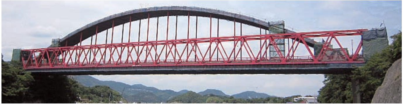
向島大橋 全景
