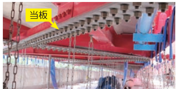
橋梁鋼材の当板補強の状況
