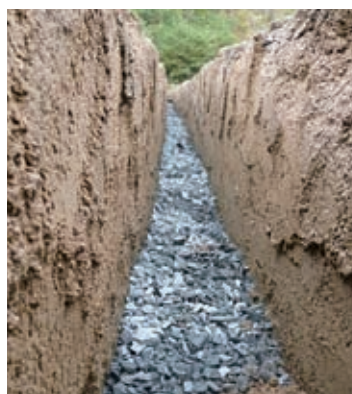
本暗渠の設置
