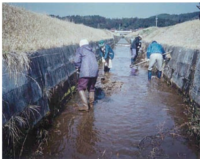
水路の泥上げ
