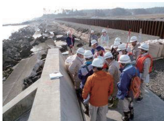
写真1 災害査定の状況
