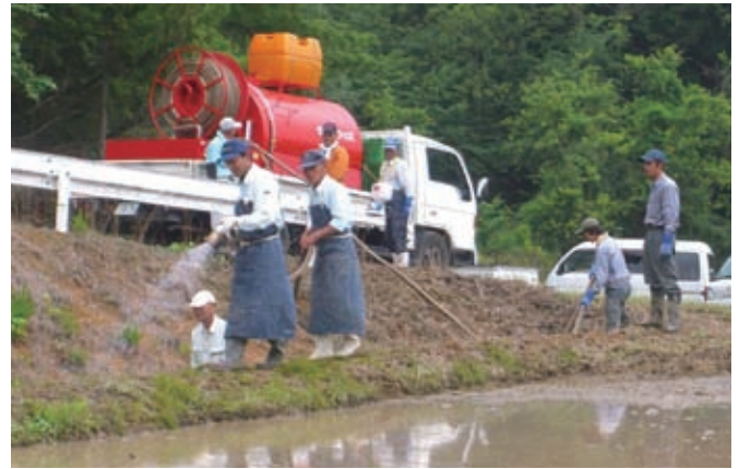
センチピートグラスの吹付作業
