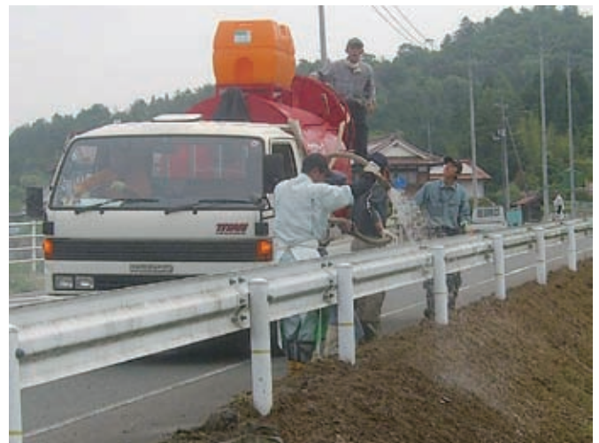
センチピートグラスの吹付作業（H24年6月）
