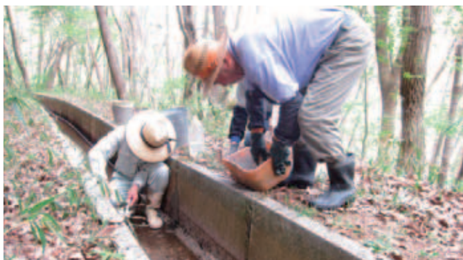
水路の目地詰め
