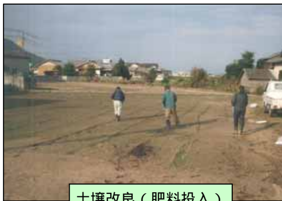
土壌改良（肥料投入）
