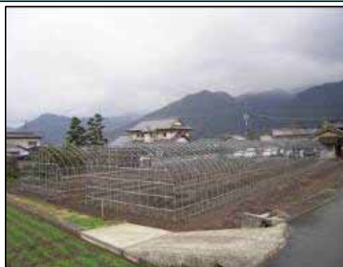
育苗ハウスの設置状況
