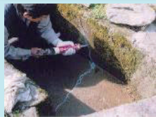
水路のひび割れ補修
