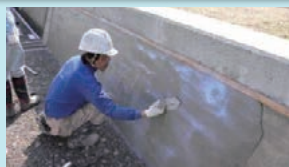
老朽化した水路壁のコーティング
