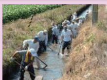
水路の泥上げ
