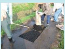
農道の部分補修
